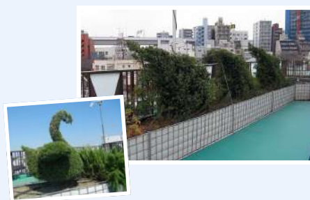
板橋明星幼稚園様（東京都板橋区）
