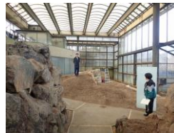
【施工前】現地調査
